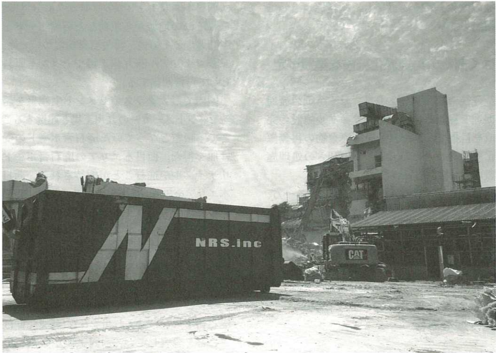
大規模解体現場では大型コンテナで回収
