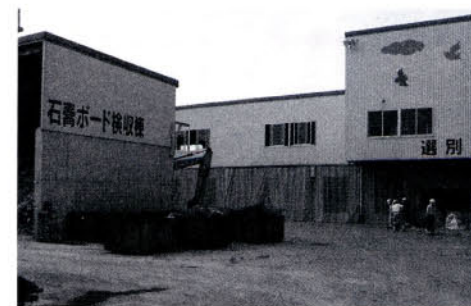
大東商事の石膏ボード検収棟
